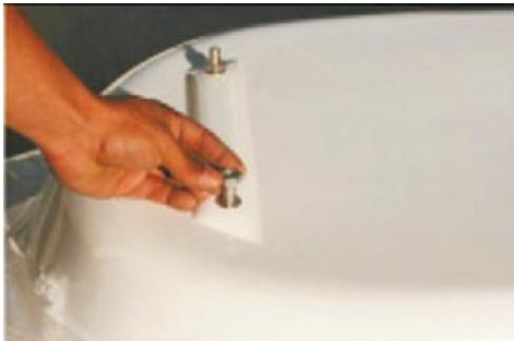
2. Положите монтажную планку к основанию ванны, совместив прорези с установочными опорами. Навинтите гайки с шайбами, зафиксировав монтажную планку. Не затягивайте гайки до конца, так как может понадобиться регулировка.
